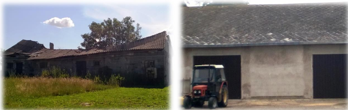
Rysunek 1. Wyroby azbestowo–cementowe: po lewej płyty faliste, po prawej płyty płaskie
